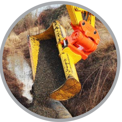
Metering Fill Material
