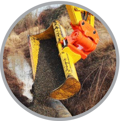
Répartition du matériau de remplissage
