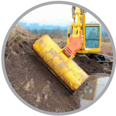
Finition de talus
