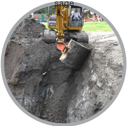
Sécurisation de tranchée
