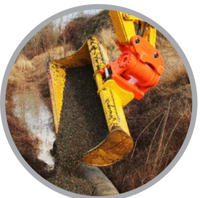
Füllmaterial dosieren
